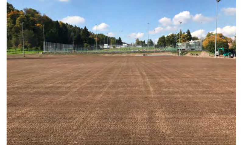
Oben: Neue Rasentragschicht, HEK Interstein Intergrün 07
