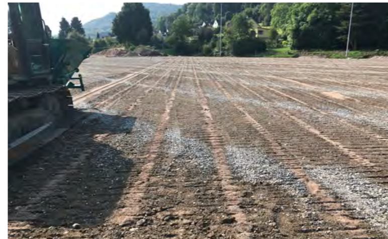
Oben: Neue Entwässerung kombiniert mit Sickerschlitzen
