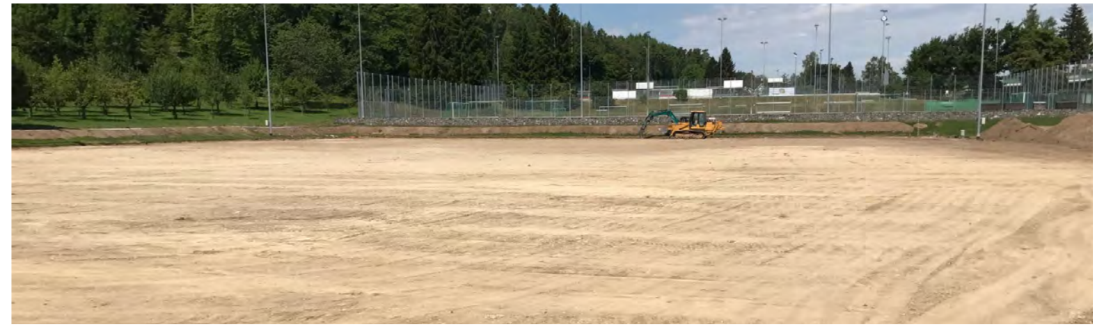
Rohplanum und Massenausgleich mit Verdichtung.
